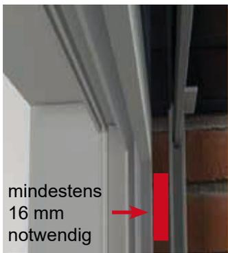
Falls bauseitig ein Rollladen montiert ist, so benötigt TEOFIX mindestens 16 mm zwischen dem Fensterblendrahmen und der Rollladen-Führungsschiene.
