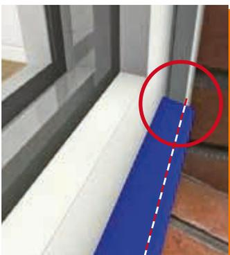
Sollten ein Wetterschenkel vorhanden sein, so darf er nicht über die Blendrahmenaußenkante stehen. Er würde beim Einbau des TEOFIX Insektenschutzelementes stören.
